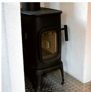
Für kalte Wintertage haben sie einen Kaminofen eingebaut: Erst wenn der knistert, geht es an die Mathe-Aufgaben.
